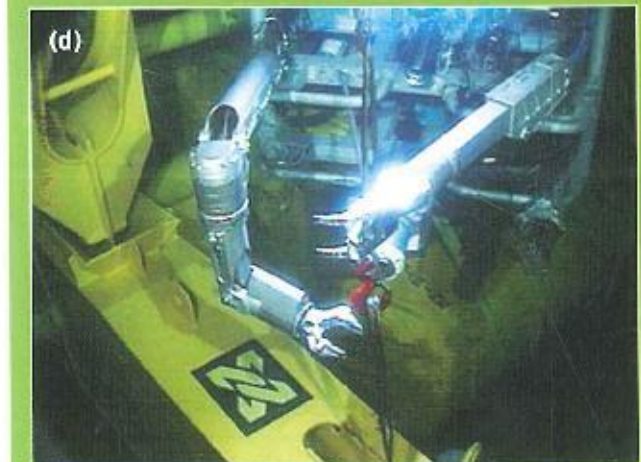
Bir vinç yardımıyla suya indirilen ROV'lar (a), sualtı kabloları (b), bakım-onarım (c) ve montaj (d) işlerinde kullanılırlar.
